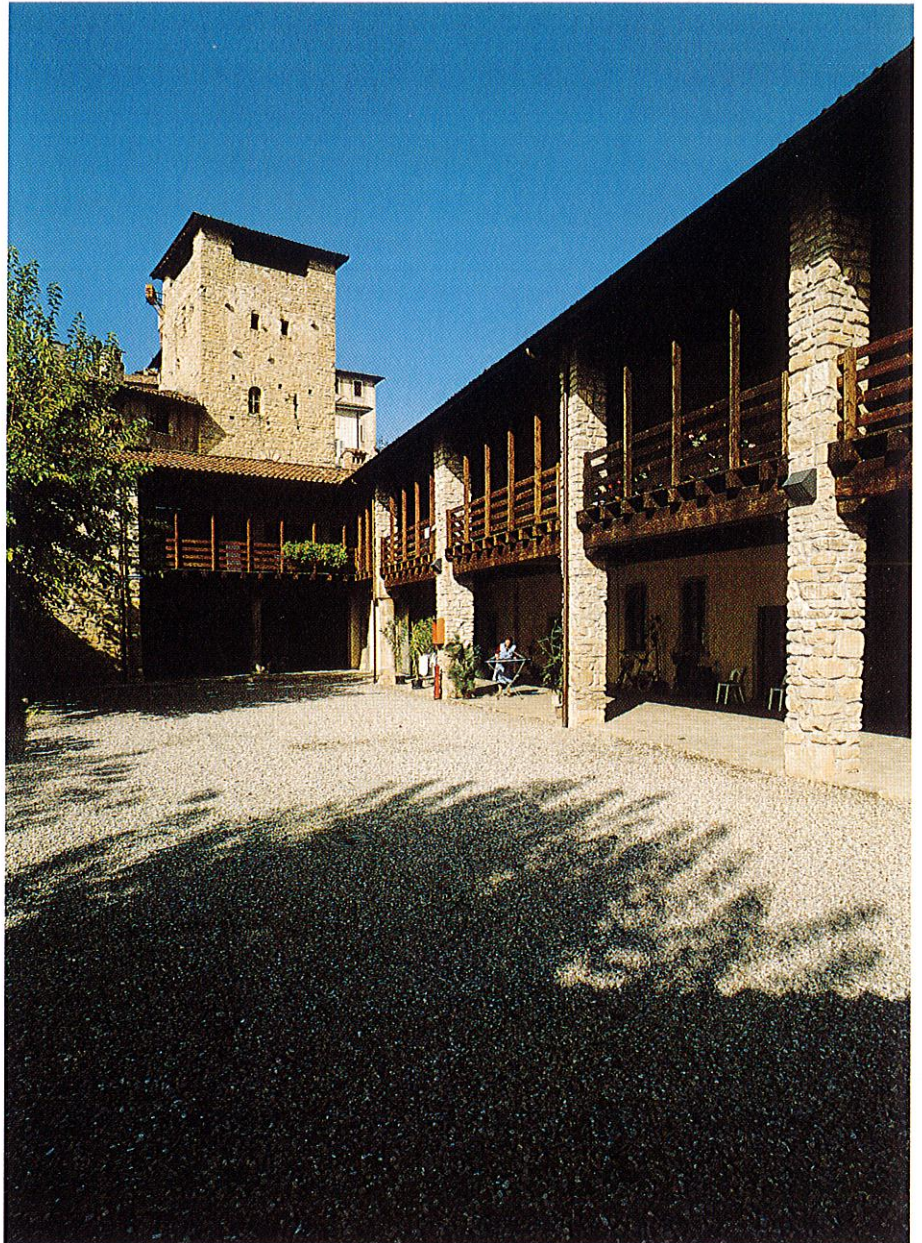
Cascina Mezzate: il loggiato ed un particolare del soffitto a volta in mattoni: «...per i tanti incendi che si compivano, fabbricavansi le stanze tutte in volta...».
