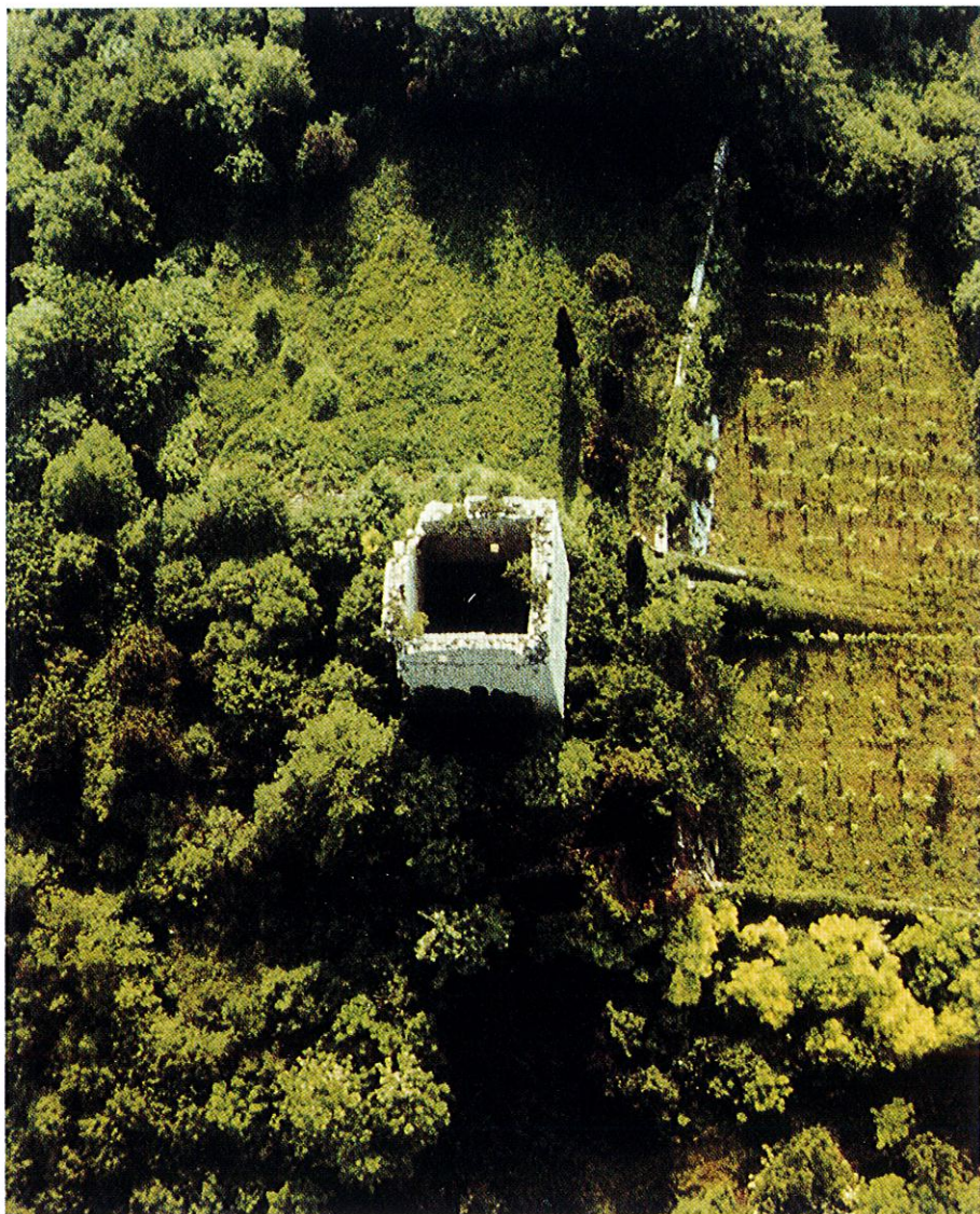
Veduta aerea della torre e del prato antistante. (Foto archivio biblioteca comunale di Costa).
